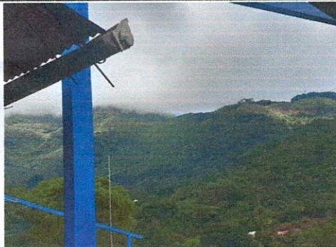
Foto 5: canales y bajadas pluviales
