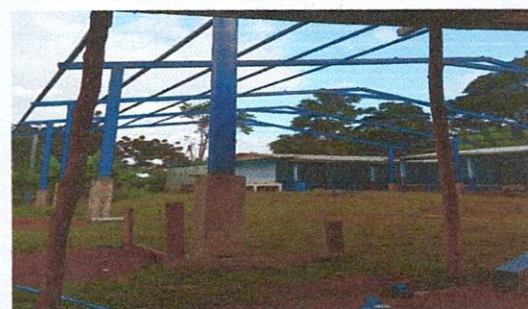
Foto 6: Mejoramiento de estructura portante
