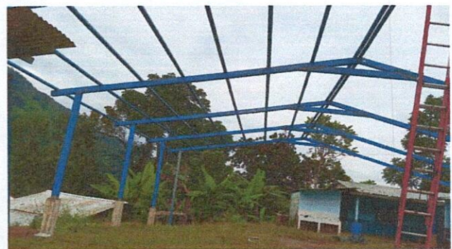
Foto 4: Estructura de techo tipo portico
