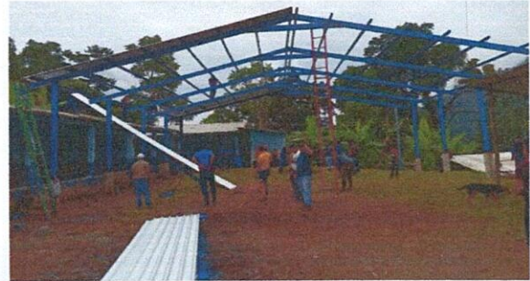
Foto 2: Cubierta de lamina troquelada C.16
