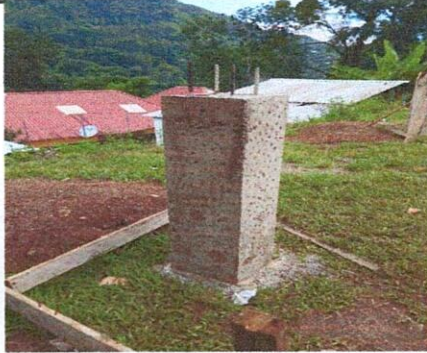
Foto1: Mejoramiento de estructura portante
