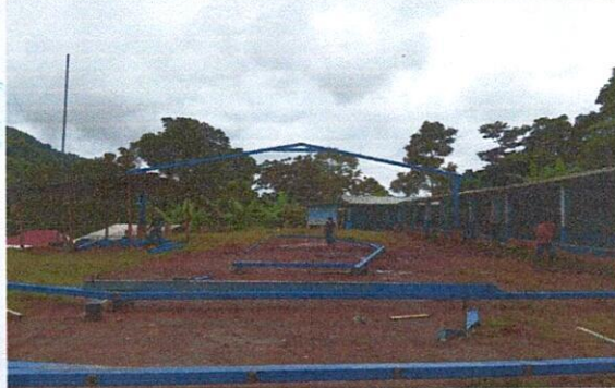
Foto 3: Estructura de techo tipo portico
